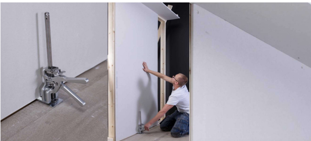
Câler les plaques, mise en place avant fixation
