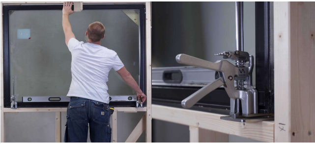
Lever et mise à niveau de fenêtres
