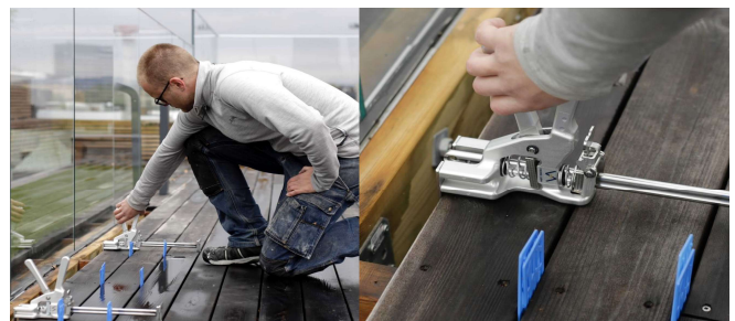
Serrage des lames pour la pose de terrasse bois
